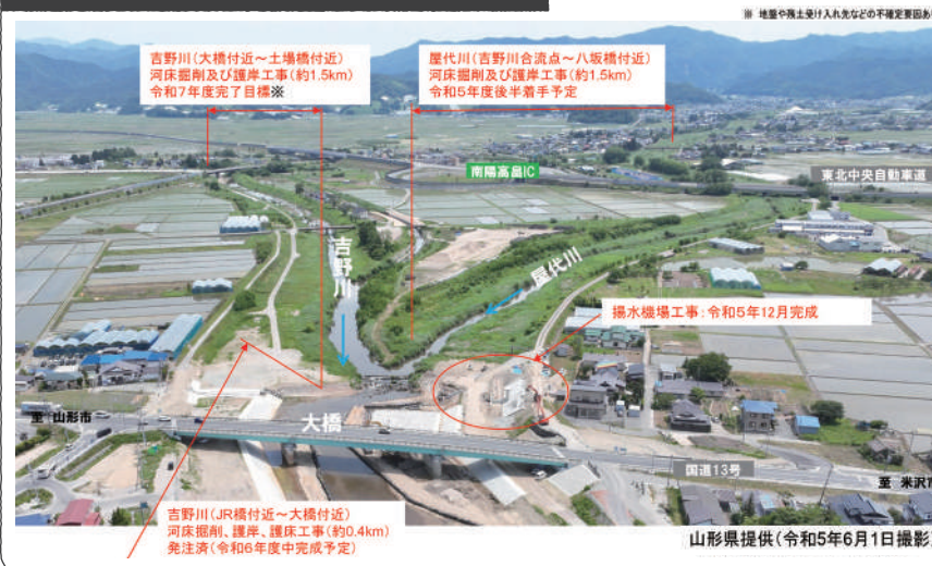
吉野川(屋代川)河川改修事業 施工状況写真(大橋付近)
