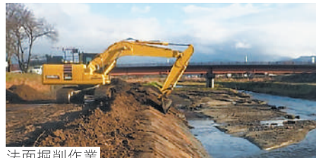
法面掘削作業
