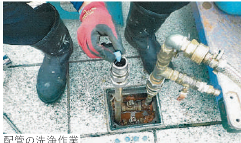
配管の洗浄作業
