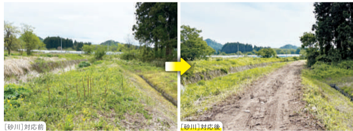
河川管理用道路 整備 砂川・土会川の堤防道路の支障木伐採
