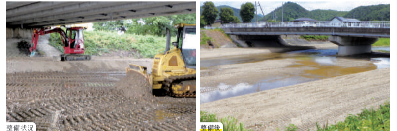
河川流下能力確保対策(支障木伐採)
