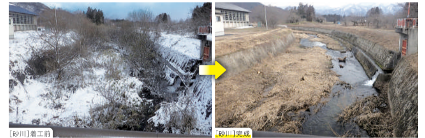
河川流下能力確保対策(支障木伐採)
