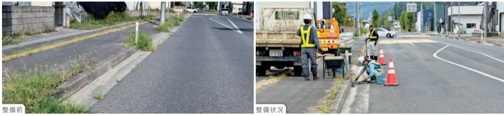
国道399号 雨水樹土砂撤去
