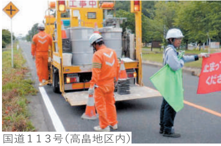
国道113号(高島地区内)
