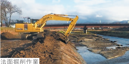
法面掘削作業
