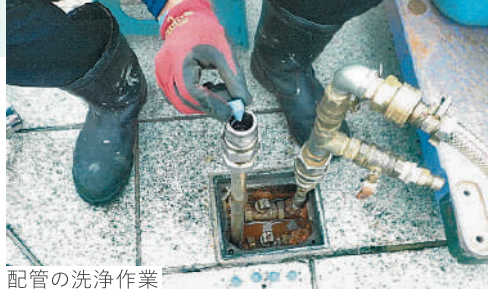
配管の洗浄作業
